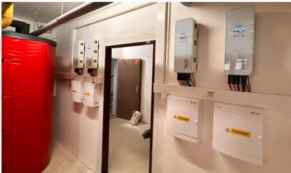
Elektroinstalace 4 jednotek ohřevu vody v bytovém domě
